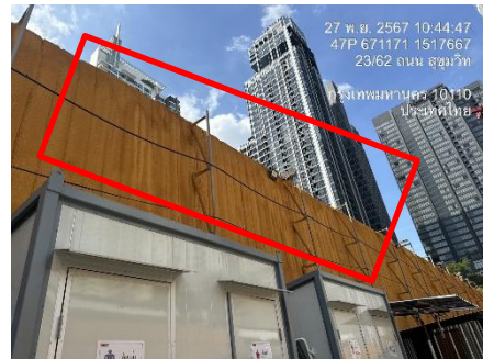
รูปที่ 18 สเปรย์พ่นละอองน้ำ
